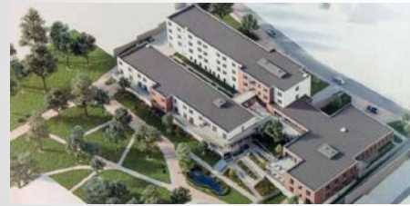
Immeuble MRS et RS / La Calamine
